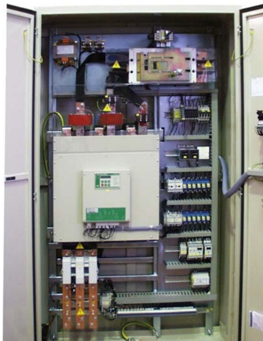
Quadro avviatore a soft-starter per elica di manovra: 440V-500kW-770A
