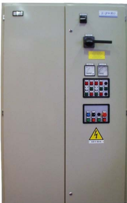
Quadro avviatore a soft-starter per elica di manovra: 440V-500kW-770A
