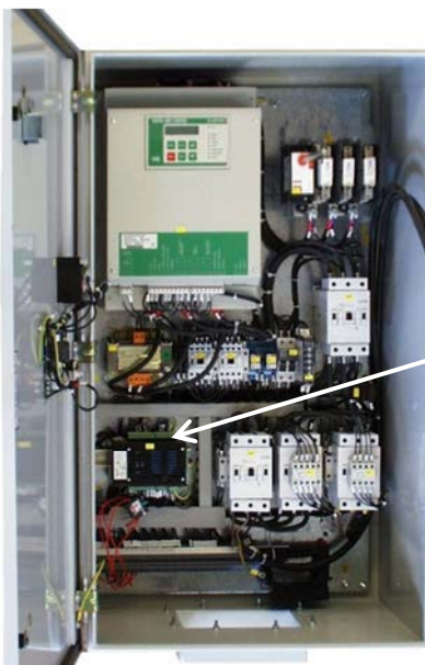
Quadro avviatore soft-starter 2 velocità per pompa acqua mare di raffreddamento: 440V-54kW-87A
