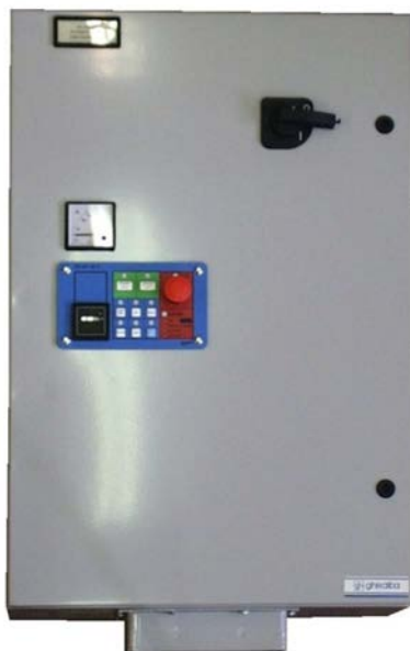
Quadro avviatore soft-starter 2 velocità per pompa acqua mare di raffreddamento: 440V-54kW-87A
